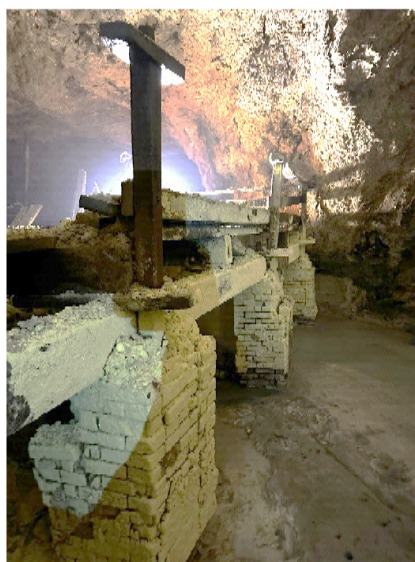
Fig. 9 - Foto di alcuni piloni della passerella interna alla grotta sudatoria allo stato di fatto.
