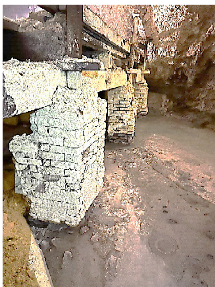
Fig. 9 - Foto di alcuni piloni della passerella interna alla grotta sudatoria allo stato di fatto.
