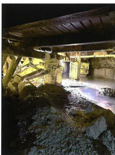
Fig. 10 - Foto dell'intradosso del pontile della passerella interna alla grotta sudatoria allo stato di fatto.
