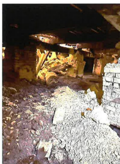
Fig. 10 - Foto dell'intradosso del pontile della passerella interna alla grotta sudatoria allo stato di fatto.
